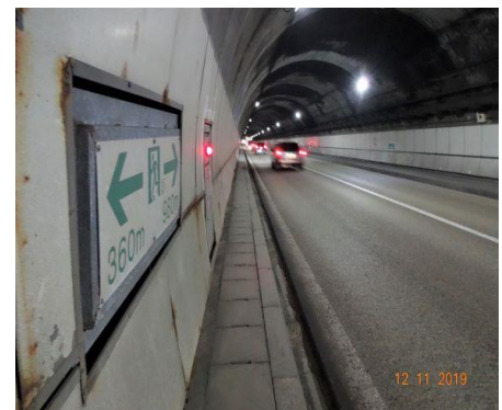
&lt;トンネルの側溝&gt;
